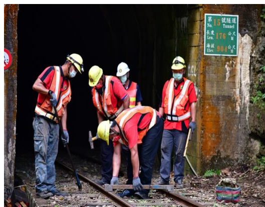
路線整修作業-量測軌距
